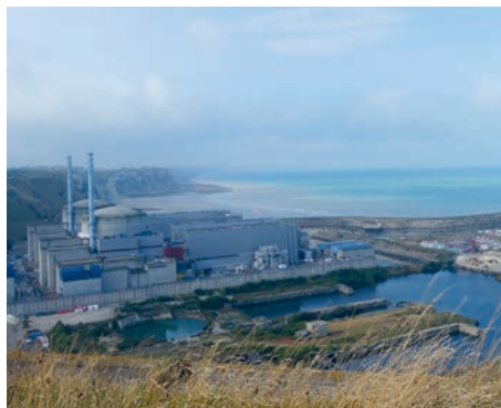
Vue générale du site EPR2 depuis le belvédère. Les fondations (d'un ancien projet) remplies d'eau pluviale ont été vidangées pour permettre la démolition des structures en béton existantes, afin d'engager les phases de terrassement.
