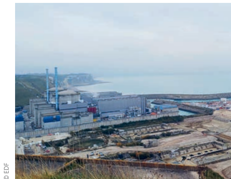
Vue générale du site EPR2 depuis le belvédère. Les fondations (d'un ancien projet) remplies d'eau pluviale ont été vidangées pour permettre la démolition des structures en béton existantes, afin d'engager les phases de terrassement.
